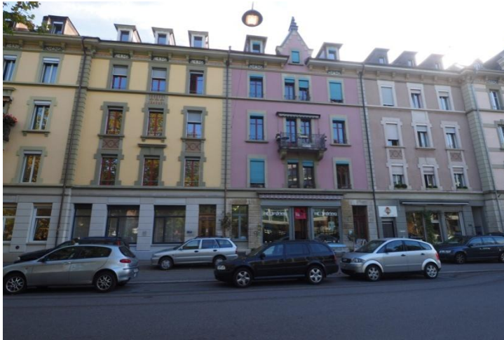
Abbildung 7: Renovierte Häuser in der vorderen Lorraine
