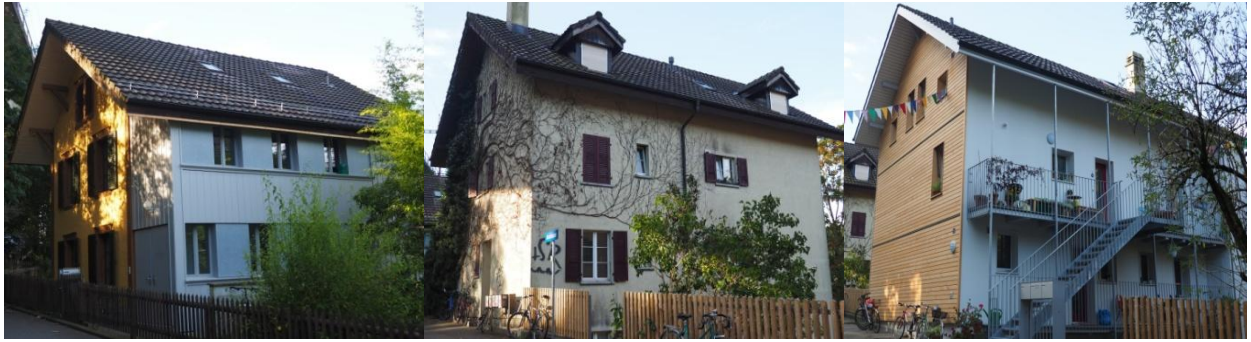
Abbildung 5: Die drei Häuser an der Jurastrasse
