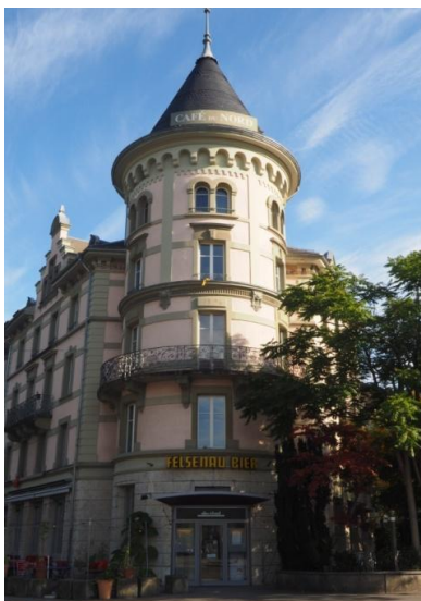
Abbildung 8: Restaurant "Du Nord"
