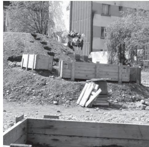
Verzögerung der Baubeginns am Centralweg
